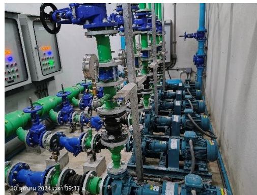
ปั๊มสูบน้ำไปยังถังเก็บน้ำอาคาร ต่างๆ
