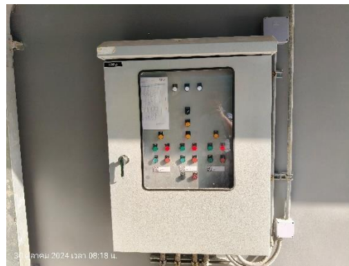
ตู้ควบคุมปั๊มสูบน้ำบ่อสูบน้ำเสีย
