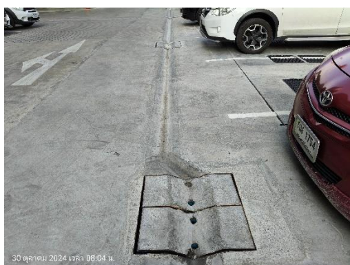
รางรับน้ำฝนไหลลงสู่ท่อระบายน้ำและบ่อพักน้ำ
