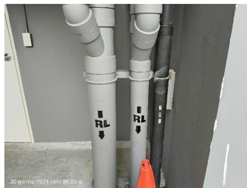
ท่อระบายน้ำฝนลงสู่รางระบายน้ำ
